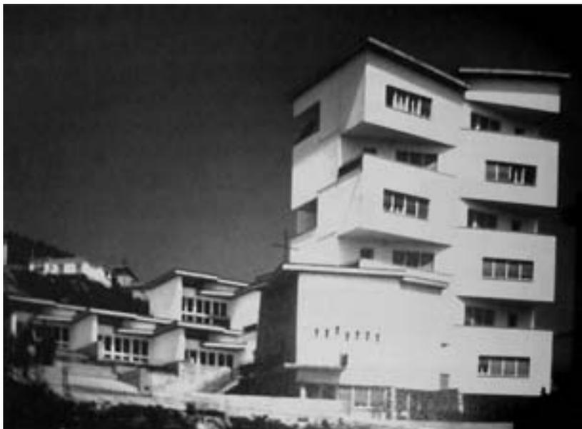
Fig. 14 – Casa per Religiose e scuola materna a Gretta (1954). L'edificio principale presenta la singolarità della «chiave architettonica» dei moduli edilizi sovrapposti ruotati alternativamente uno sull'altro.
