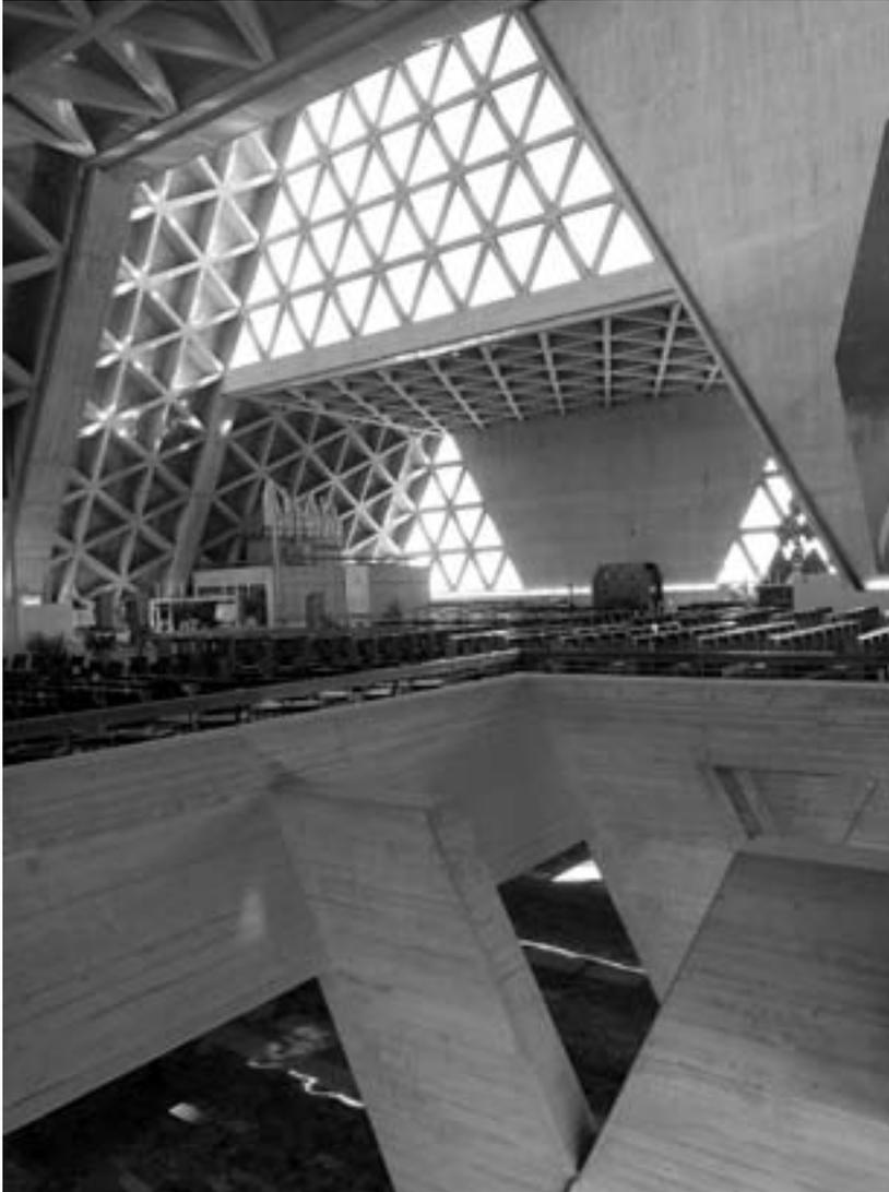
Fig. 20 – Transetto sud con l'altare del Santissimo – a destra – e le sacrestie – a sinistra. Prevale la sezione trapezoidale degli spazi e vi si coglie la netta demarcazione tra superfici vetrate e superfici cieche. In primo piano, nel vuoto dell'asola tra chiesa superiore e inferiore, la struttura portante dell'ordine superiore, anch'essa risolta con l'angolazione del triangolo d'Eulero.
